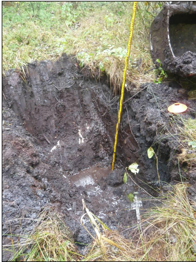
Bilde 2-7: Bilde av sjakt SJ3 i den sørlige delen av nedre deponi.
