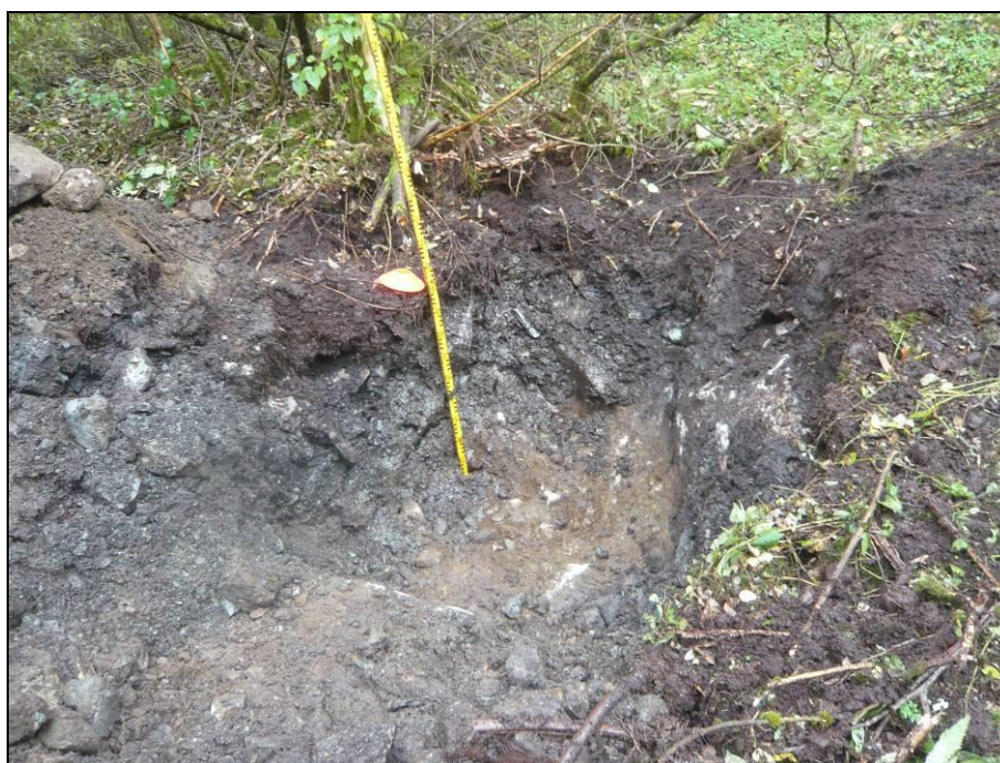
Bilde 2-2: Bilde av sjakt SJ5.
